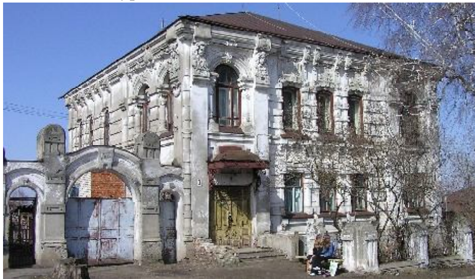
Дом В.В. Преснякова, 1907 г. (ул. Красная горка, 3). Объект культурного наследия регионального значения.
